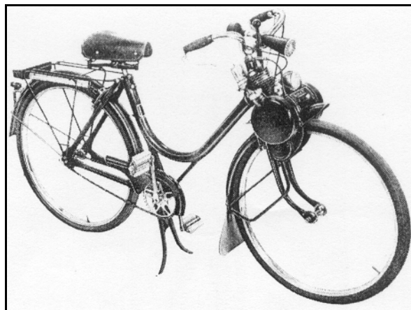
Fig. 48. VeloSolexmaskin komplett sådan den kommer från Frankrike. Ramen är kraftigt tilltagen och passar såväl för herre som för dam. Dekompressionsventil finns. Cylindervolymer är 45 cm 3 och effekten är 0,4 hkr. Drivning med rulle. Förgasaren saknar munstycke. I stället finns ett membran som pumpar bränsleblandning in i vevhuset.
